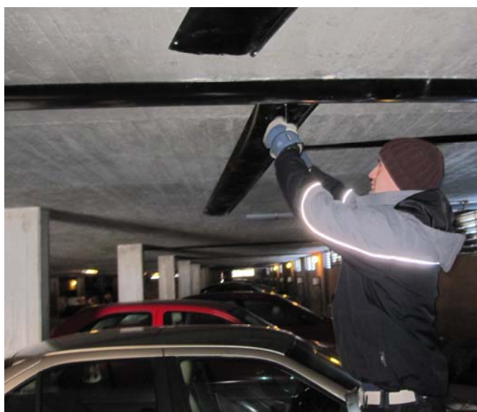
Anders undersöker betongkonstruktionen i kallgaraget
